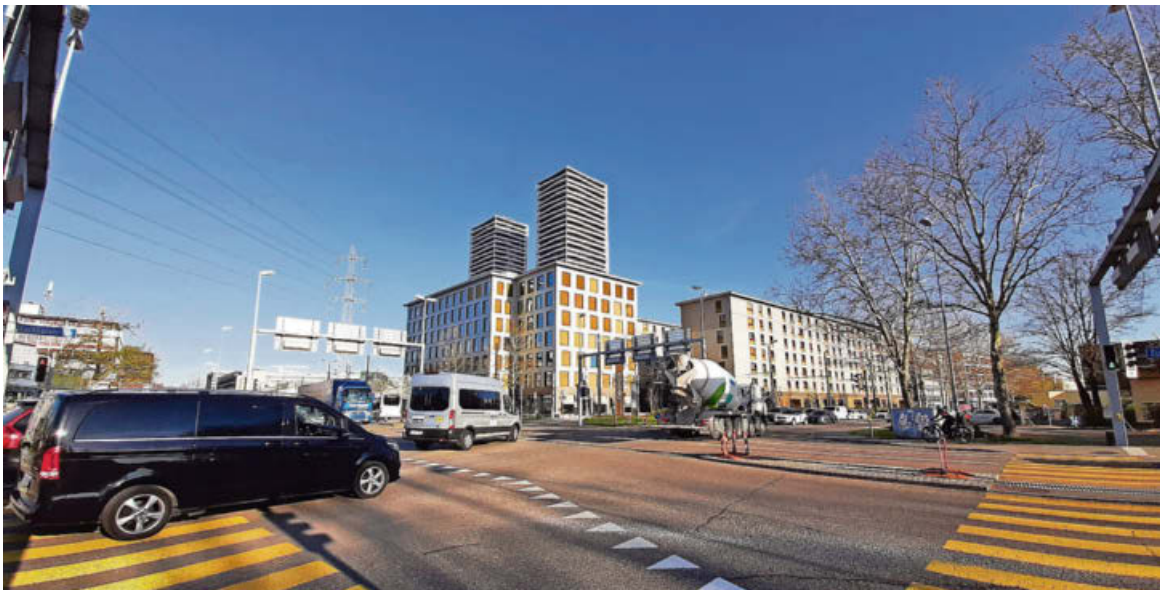
Die Sonnentäl-Kreuzung in Dübendorf wenige Tage vor dem Beginn der Bauarbeiten.
